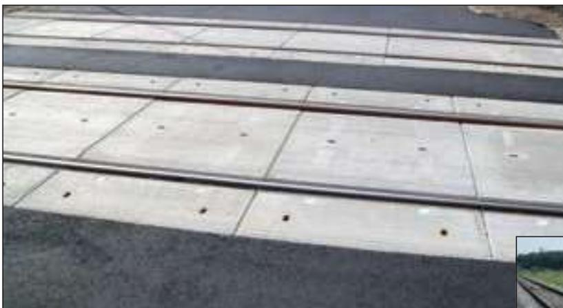
Dalles en béton armé ( résistance, économie, rapidité de pose, confort des usagers...)
