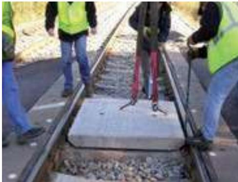
Pose de la 1ère dalle dans l'axe du passage à niveau
