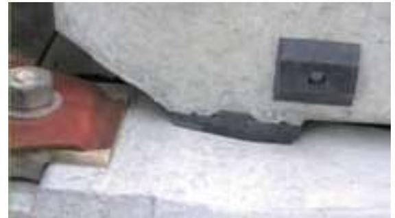
Détail d'un appui caoutchouc des dalles MONODAL®
