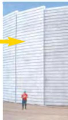
Le réglage en alignement et en verticalité se fait facilement grâce à un dispositif original de vérins à vis. Chapsol fournit le plan de ferrailage des armatures nécessaires à la réalisation sur place de la semelle B.A. Des réservations permettent la mise en place des aciers. Sur demande, Chapsol peut aussi fournir les armatures.
