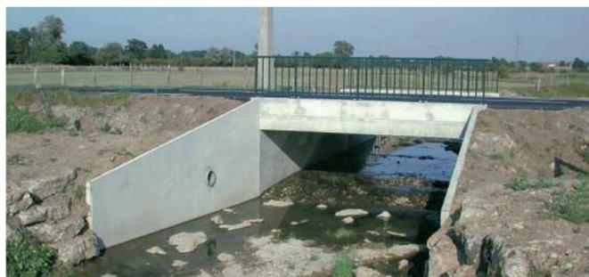
Ouvrage U + Dalle + Murs de sortie d'ouvrage ouv. 5,00 m x ht 1,70 m
