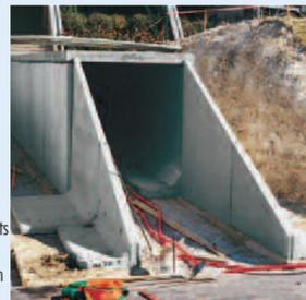
Étanchéité par larges bandes bitumineuses
