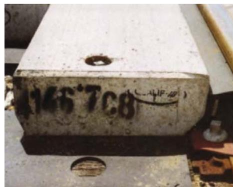
8 Les trous de manutention et de fixation, au dessus et au-dessous de l'appui des tirefonds, sont renforcés par un blindage acier. Ils sont équipés d'un dispositif de sécurité à la manutention.
